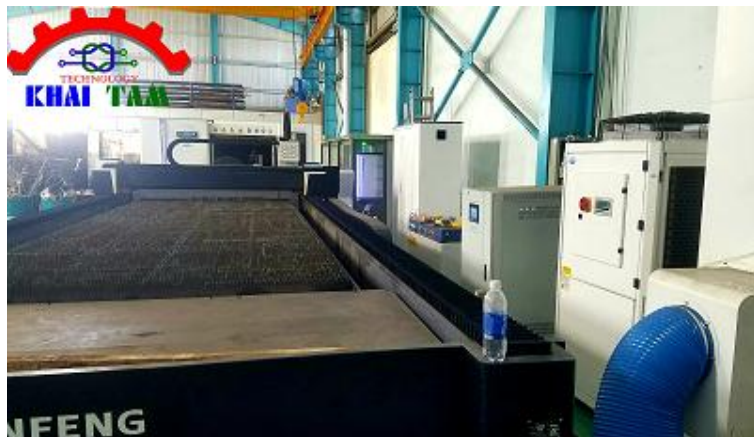
Lắp máy cho hãng SenFeng-Nhon trạch-Đồng Nai
