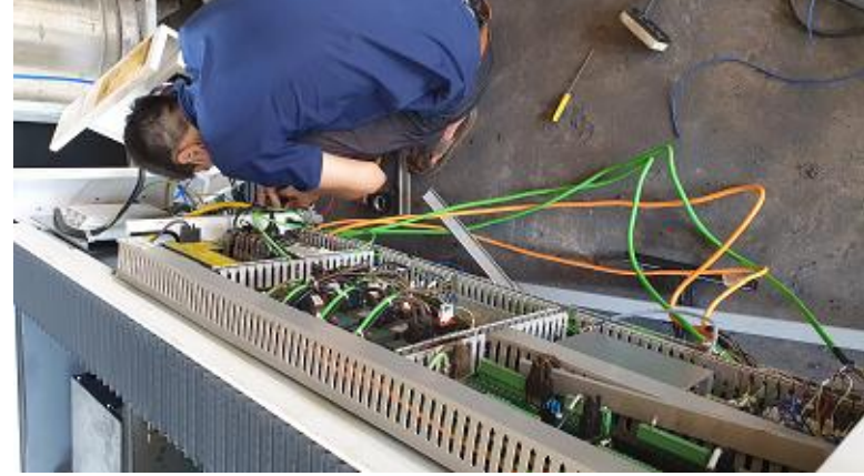
Làm lại tủ điện máy Bodol-Bình Dương
