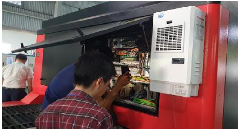
Sửa chữa đầu lại tủ điện máy Senfeng-Vũng Tàu
